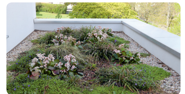
Verlegte Staudenmatten für schattigen Standort auf einem Flachdach der degewo AG in Berlin-Lankwitz.
